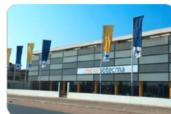
Edifício em Luanda
